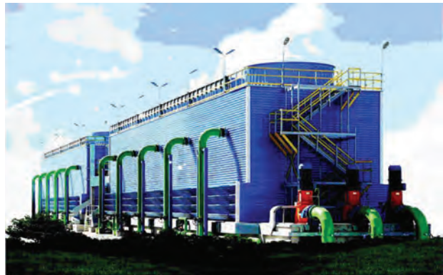
Fan cooling tower
