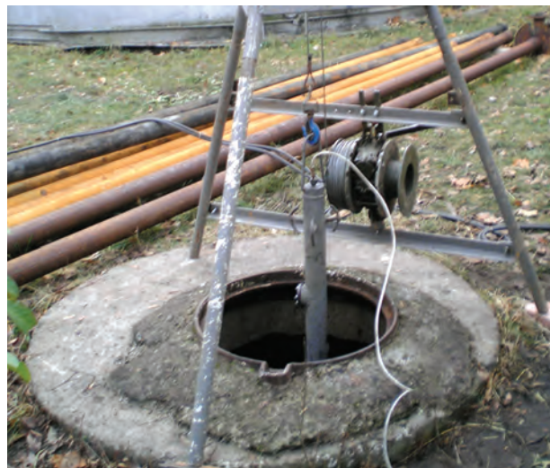
Відновлення дебіта водозабірної свердловини № 3754, розташованої в м. Ірпінь
