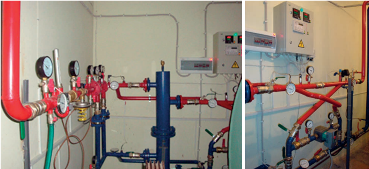
Індивідуальний тепловий пункт із гідравлічною стрілкою (залежна схема підключення до тепломережі)
