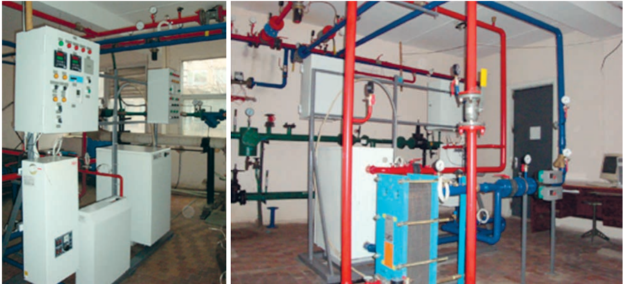
Індивідуальний тепловий пункт із електричними котлами (незалежна схема підключення до тепломережі)
