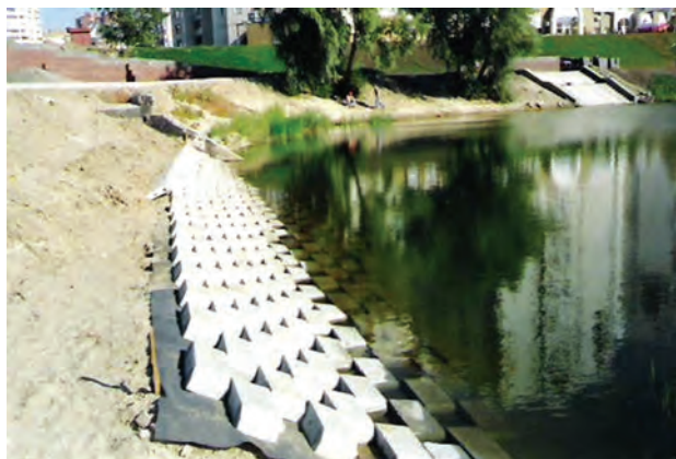
Гнучке кріплення берегу оз. Позняки, м. Київ, з використанням «Тексівод»
