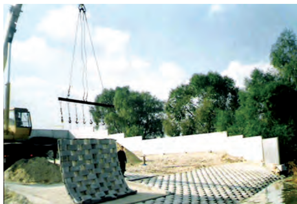
Процес улаштування гнучкого кріплення
