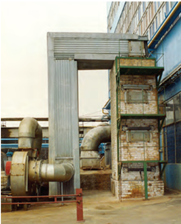
Теплоутилізаційна установка з теплоутилізатором ТВМ-20 за піччю № 3 Гостомельського скляного заводу (Київська обл.)
