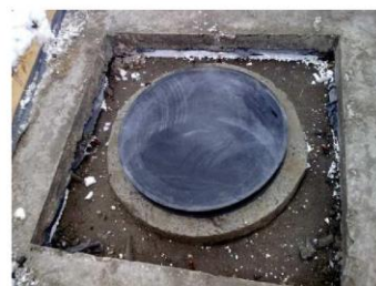
Загальний вигляд гумового віброізолятора діаметром 500 мм на оголовку палі (Оболонський проспект, м. Київ)
