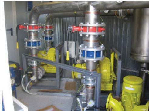
Система подачі звалювального газу до поршневої електростанції
