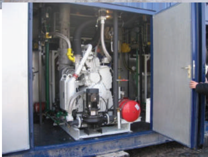
Газова електростанція на базі двигуна “TEDOM” (Чехія) потужністю 185 кВт
