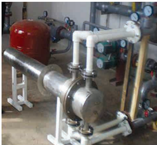
Змонтований і встановлений теплообмінник
