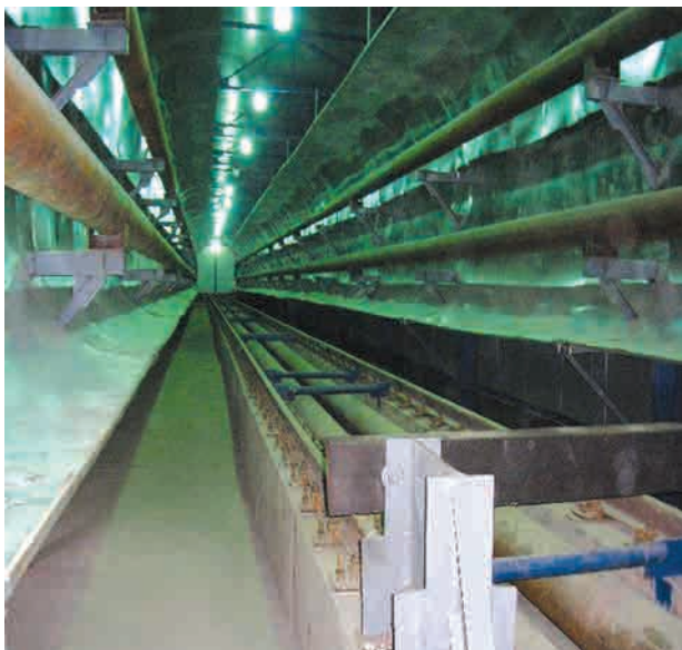
Внутрішній простір гаража-розморожувача з випромінювальними трубами та екранами
