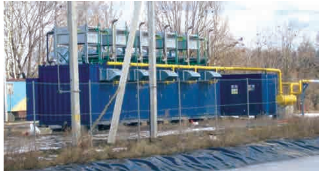
Комплекс з переробки звалищного газу продуктивністю 1 МВт
