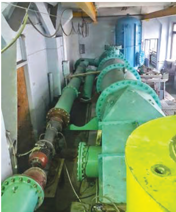
Установка для випробувань мікроГЕС на стенді ЕКС-15
