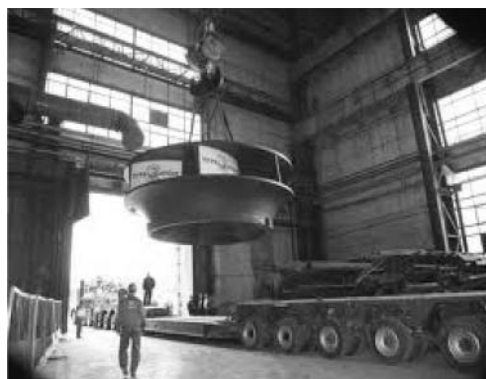
Спіральна камера та робоче колесо насос-турбіни Дністровської ГАЕС
