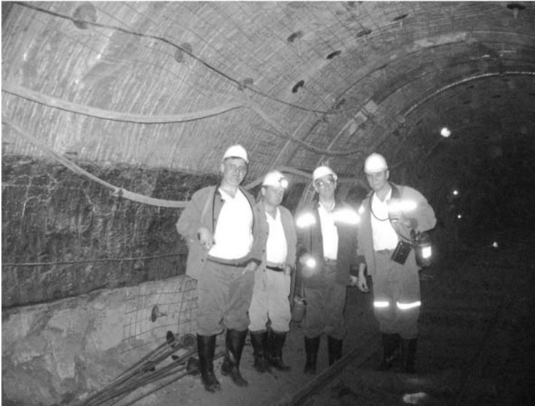
Стан гірничої виробки вугільної шахти при застосуванні технології опорно-анкерного кріплення
