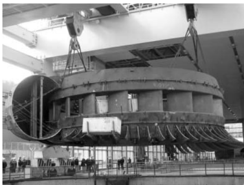
Спіральна камера та робоче колесо насос-турбіни Дністровської ГАЕС
