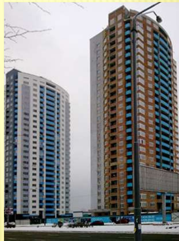
27-поверхові житлові будинки з системою вібросейсмозахисту на відстані 20 м від лінії метрополітену (Оболонський просп., м. Київ)
