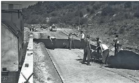
Початок будівництва лабораторій відділу фотоядерних процесів
