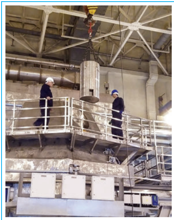
Будівля для ядерної підкритичної установки "Джерело нейтронів"
