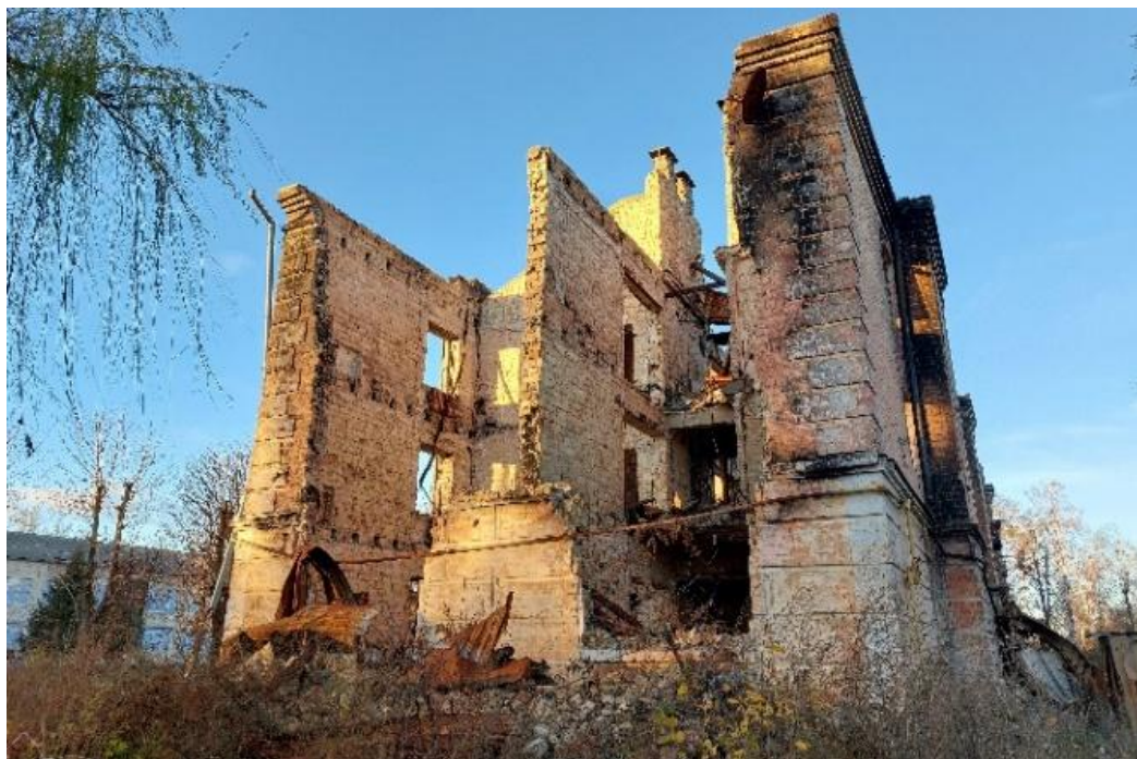
Рис. 2.41. Зруйновані житлові будинки у містечку для військових у Гостомелі, жовтень 2022 р.
