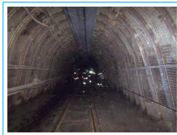
*Стійкий стан гірничої виробки з анкерно-рамним кріпленням під час її проведення в зоні високоамплітудних геологічних порушень*
